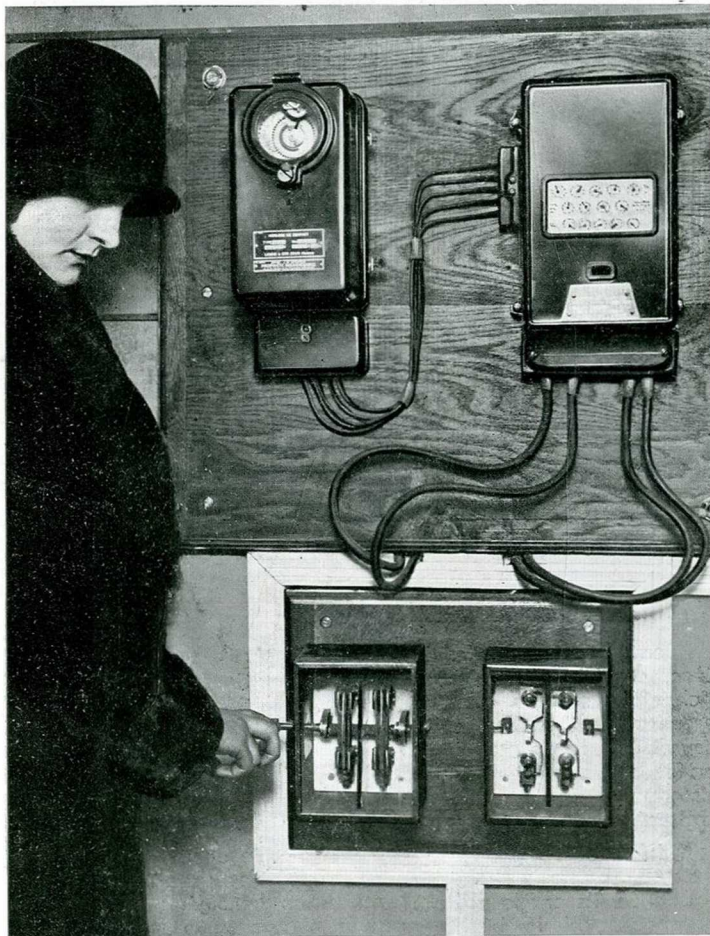
Chez les usagers du chauffage électrique, désirant bénéficier des tarifs réduits, les secteurs posent des compteurs spéciaux, munis d'une horloge, qui, suivant les heures d'utilisation, fait enregistrer la consommation aux différents tarifs. (A Paris, alors que le courant de jour pour la lumière est facturé 0 fr. 17 l'hectowatt-heure, le courant de nuit pour le chauffage ne coûte que 0 fr. 0317.)
